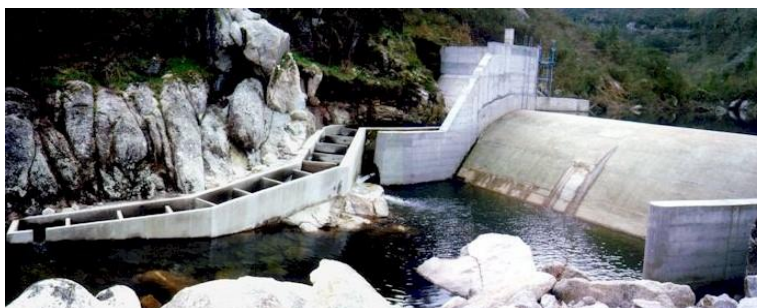
Figura 11 - Barragem de nível em concreto. Fonte: (SILVA V. M., 2009)
