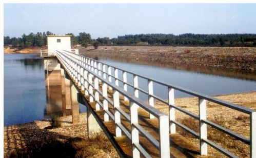
Figura 13 - Torre de tomada com passarela. Fonte: (SILVA V. M., 2009)
